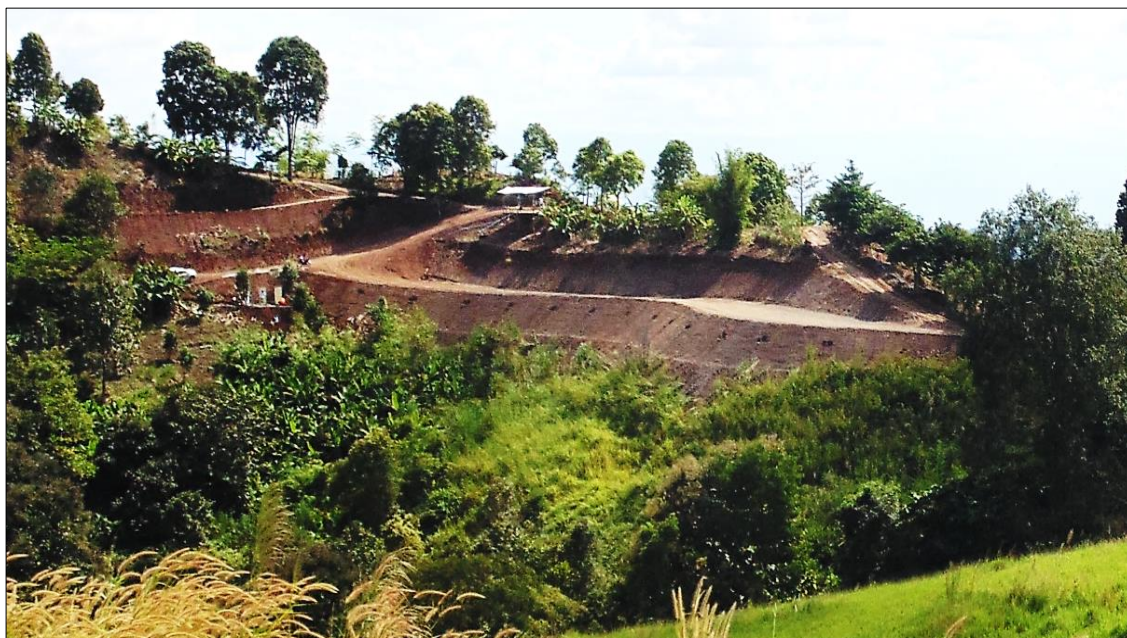
ภาพที่ ๔-๓๓ การปรับพื้นที่โดยการขุดดินหรือถมดินบริเวณเนินเขาพื้นที่ก่อสร้างรีสอร์ท ต.เขาค้อ อ.เขาค้อ จังหวัดเพชรบูรณ์จากการสำรวจข้อมูลในภูมิประเทศเมื่อเดือนธันวาคม พ.ศ.๒๕๕๙
