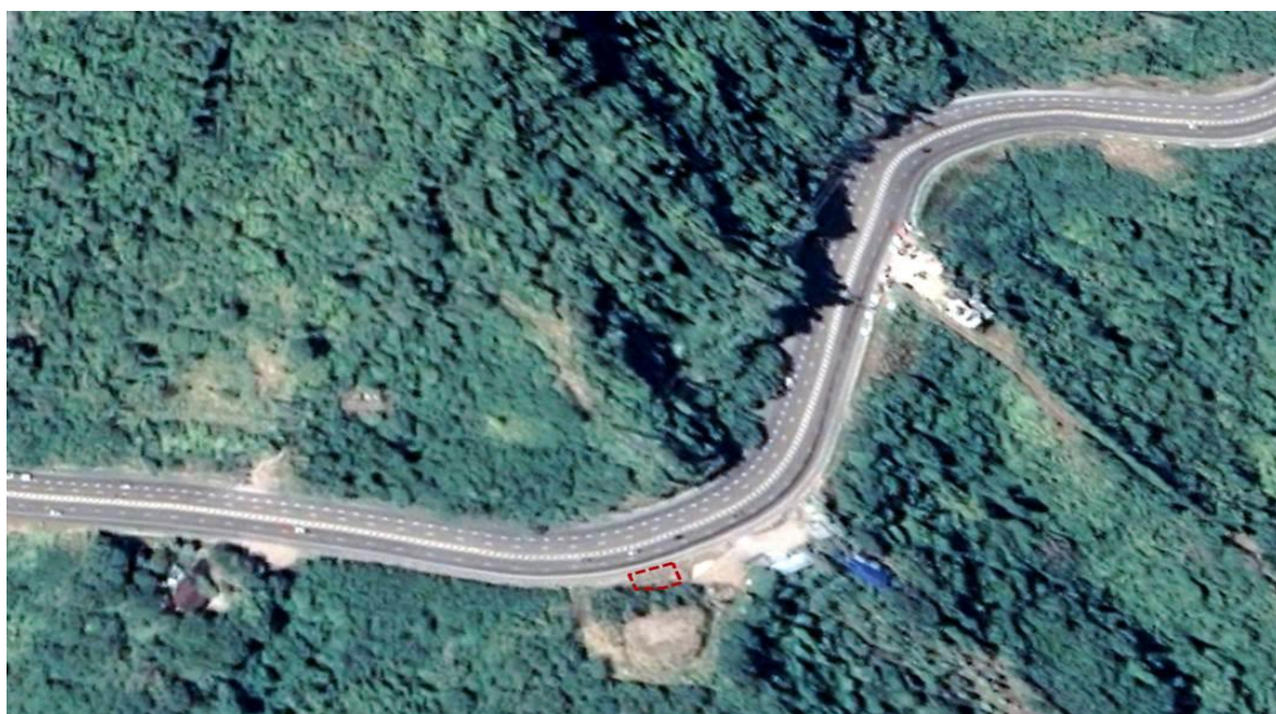
ภาพที่ ๔-๓๗ ภาพถ่ายจากดาวเทียมกลูเกิลเอิร์ท พ.ศ. ๒๕๕๖ พื้นที่ดินถล่มบริเวณไหล่ถนน ทางหลวงหมายเลข ๑๒ พิษณุโลก-หล่มสัก ตำบลแคมป์สน อำเภอเขาค้อ จังหวัดเพชรบูรณ์
